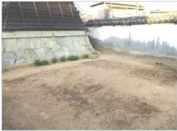
基礎・敷石をするため一旦墓を撤去する
